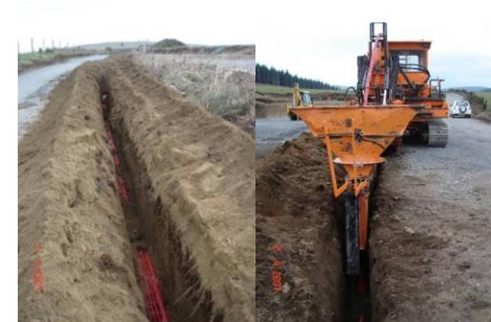
▲ Réalisation de la tranchée et de la pose du câble
