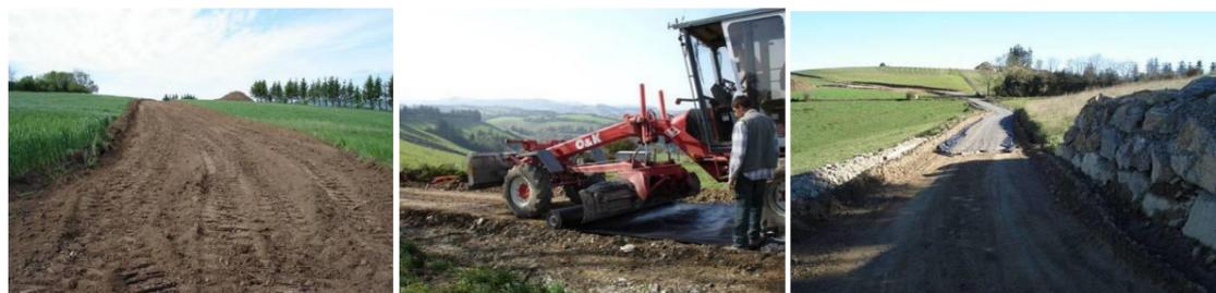
Illustration 14 : Tracé de la piste | Illustration 15 : Pose du géotextile | Illustration 16 : Mise en place du gravier
